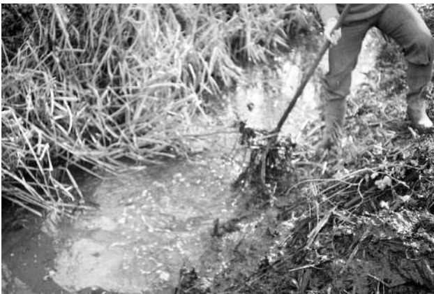
Un ponton de puisage sur la rivière. Le curage d'un fossé.
