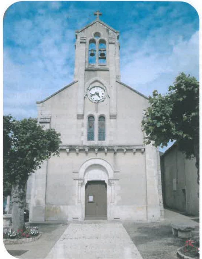
La façade de l'église de Brion. Cliché D. Bourdu
