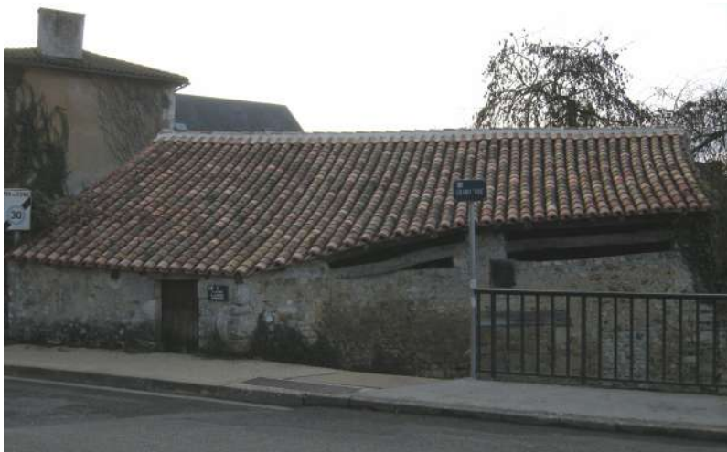
Le local restauré d'une tannerie de Lavausseau, au bord de la Boivre.
