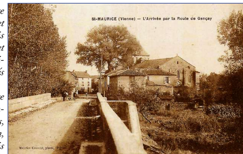
L'ancien pont sur la Clouère, avec son parapet en pierres, et la descente vers le lavoir
